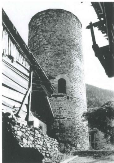
1,8 m stark. Der Turm selbst weist zu ebener Erde eine Mauerstärke von 2 m auf und verjüngt sich nach oben nur unwesentlich. Der Hocheingang liegt in einer Höhe von über 7 m. Hier wie an der Wehrmauer finden sich Reste ausgestrichener Mörtelfugen.
