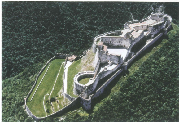
Beseno, Luftbild der Burg mit Blick nach Süden
