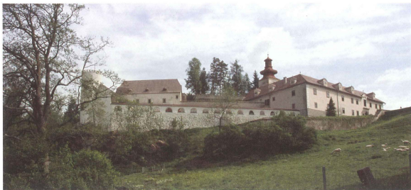
Anlage aus dem Süden gesehen
