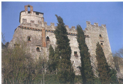
Sabbonara bei Avio, Wohnbau
