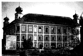
Schloß Gleinstätten, nach Revitalisierung und Horizontalisolierung
