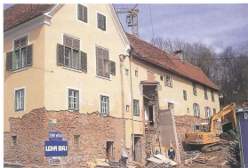
Graz, Schloß St. Peter, Beginn der endgültigen Sanierung, 1991
