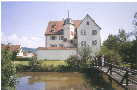
Kirchsittenbach in Mittelfranken. Der 1590 erbaute kleine Anstutz ersetzte eine ältere Burg an gleicher Stelle. Die Bauherren – die bekannte Familie Strohmayer – illustrierten mit den Schlüsselscharten und dem Wassergraben das traditionelle Privileg, sich baulich befestigen zu dürfen
