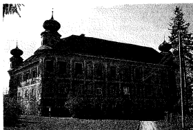
Schloß Gleinstätten, ursprüngliches Schadensbild vor Revitalisierung
