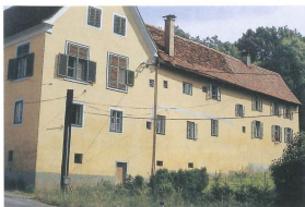
Graz, Schloß St. Peter, Feuchtigkeitsschaden tritt wieder auf, 1989
