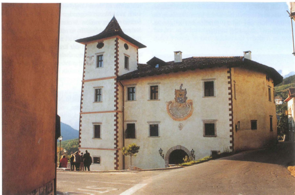
Revò, Palazzo de Maffei
