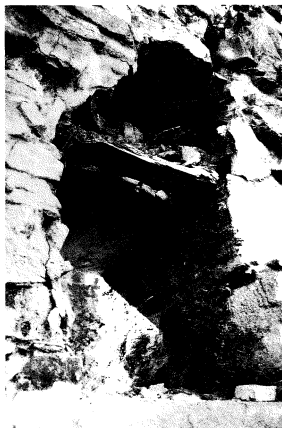
Bergfried, Fenstereinsturz im fünften Geschoss der Nordwestwand
