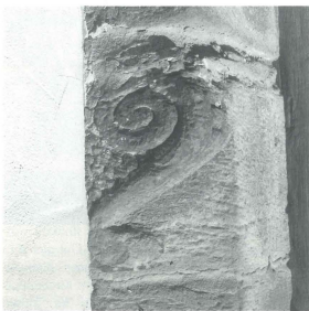
Ausschnitt Tor, Sandsteingewände mit Volute am Fassensatz
