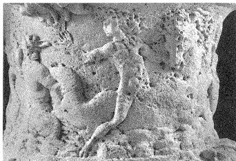
8.2 Ein während vieler Jahrzehnte unkontrolliert wirksamer Algenwuchs hat diese feinen Modellierungen einer um 1690 von Giovanni Stanetti geschnittenen Sandsteinvase verschädigt; Zustand nach Reinigung, vor Verkitzung der bis zu einem Zentimeter tiefen Löcher und vor bewuchsverhindernder Imprägnierung, die allerdings periodisch wiederholt werden muß.
